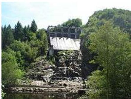
A partir de l'hiver 1925-26 les ingénieurs profitèrent des crues pour retenir une certaine partie de l'eau afin de « tester » le barrage. Le 25 avril 1926, à la suite d'une crue plus forte que les autres, l'eau atteignit sa cote maximale et il fallut même faire fonctionner le déversoir.
