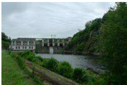
Barrage de La Roche au Moine
